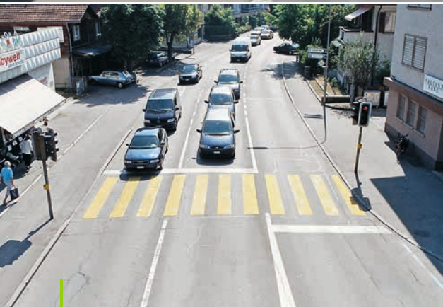
Tempo-30-Zone in Köniz: Teil Sonnenweg heute (oben) und vor der Umgestaltung (unten).
