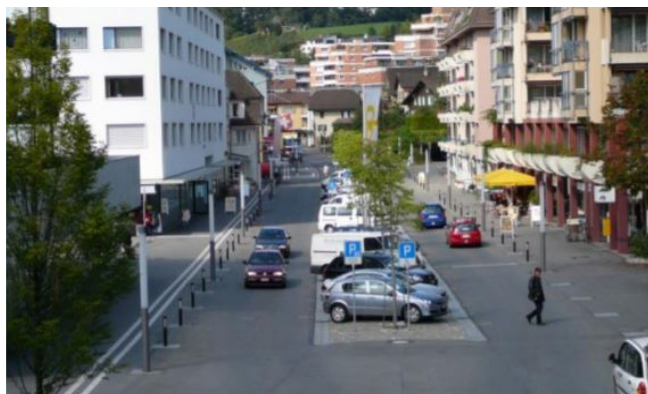
Abb. 7: Die Umgestaltung der Kantonsstrasse im Zentrum von Horw (LU) beinhaltet auch die Einführung einer T30-Zone.
