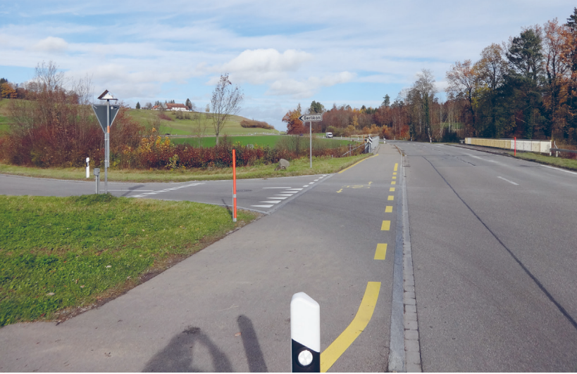
Hauptstrasse Aadof-Häuslenen mit Abzweiger nach Gerlikon, Velo hat Vortritt auf Radweg bei dieser Strasse, die im Kanton Zürich liegt.
