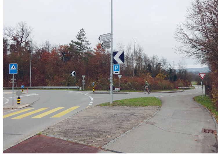
Hauptstrasse Frauenfeld-Warth mit Abzweiger Richtung Kaserne Auenfeld, Auto hat Vortritt, wenn es den Radweg quert, Velo fahrende sehen rechts abbiegende Autos schlecht und zu spät.
