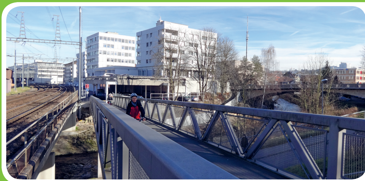
Neue Radwegbrücke über die Murg in Frauenfeld mit im Bau befindlicher Abfahrt zur Unterführung.
